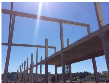
Figura 2 - Estrutura pré-fabricada em processo de montagem
