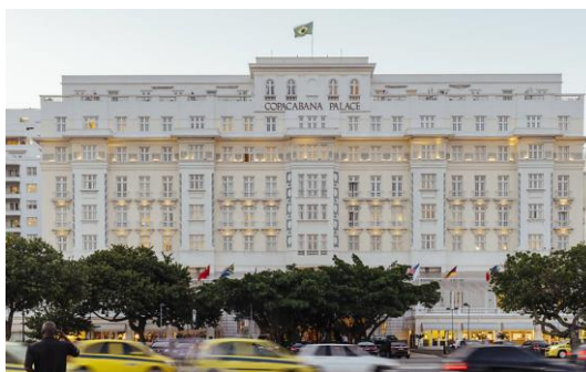
Figura 3 - Copacabana Palace, Obra do Joseph Gire 1923
