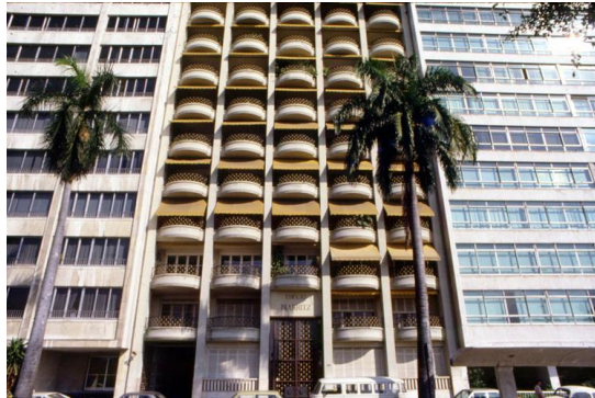
Figura 6 – Edifício Biarritz, obra de Henri Sajous
