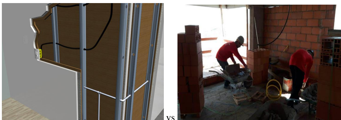
Figura 5: Projeto 3D de fechamento de Drywall X Fechamento interno com alvenaria de blocos cerâmicos. Fonte: Autor (2017)
