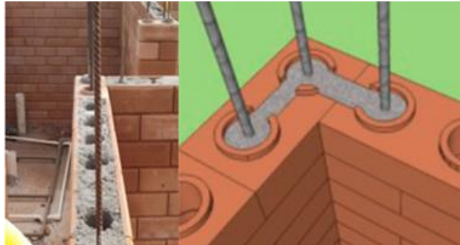
FIGURA 11 – EXEMPLOS DE GRAUTE E CINTA DE AMARRAÇÃO
