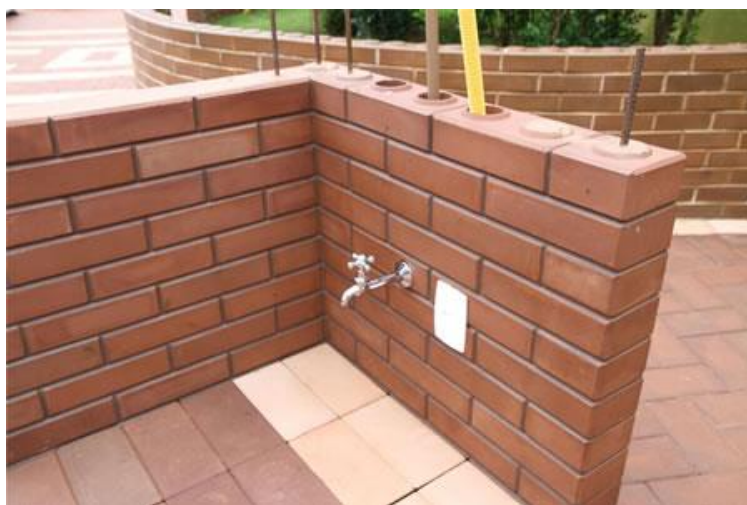
FIGURA 13 – PAREDE FEITA DE TIJOLO ECOLÓGICO
