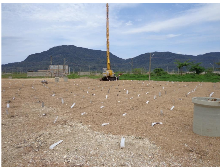
Fonte: Autoria Própria Figura 2 – Cravação dos geodrenos na área A-1
